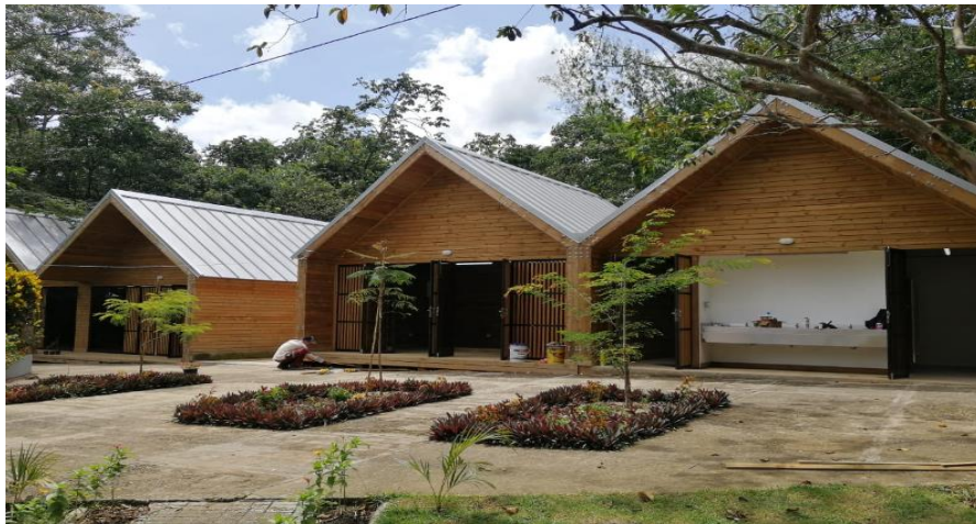
Imagen 14. Módulos Madera Cafetería y oficinas Relleno Sanitario La Pradera
