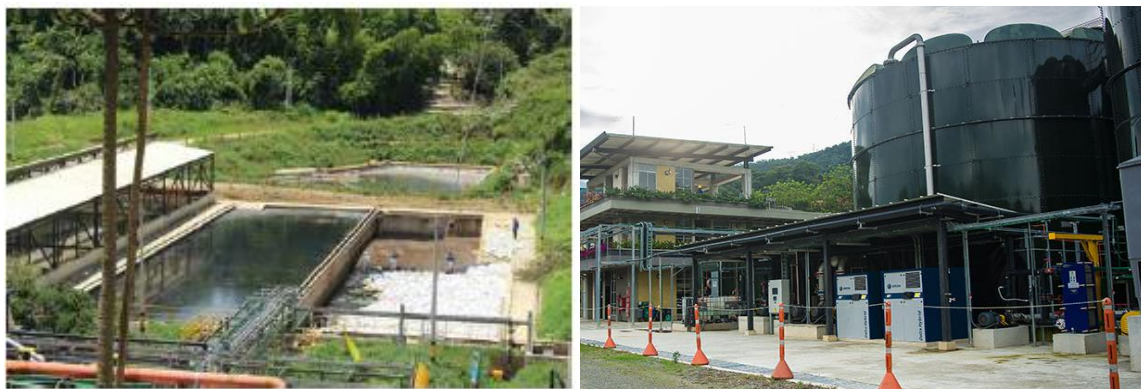
Imagen 13. Planta de tratamiento de lixiviados
