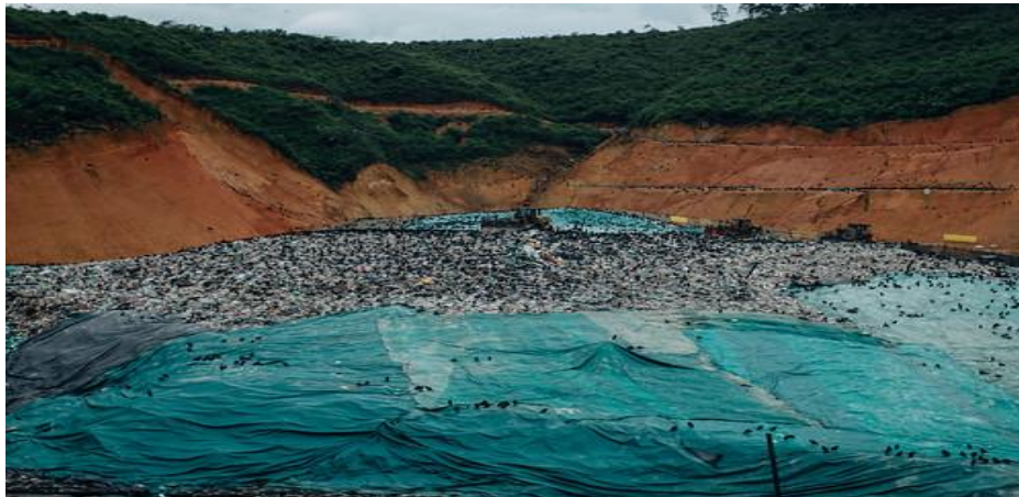
Imagen 12. Vaso Altaír-Relleno Sanitario La Pradera.
